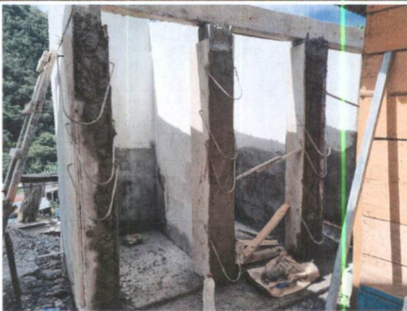
Foto 3: Mejoramiento de servicios sanitarios
