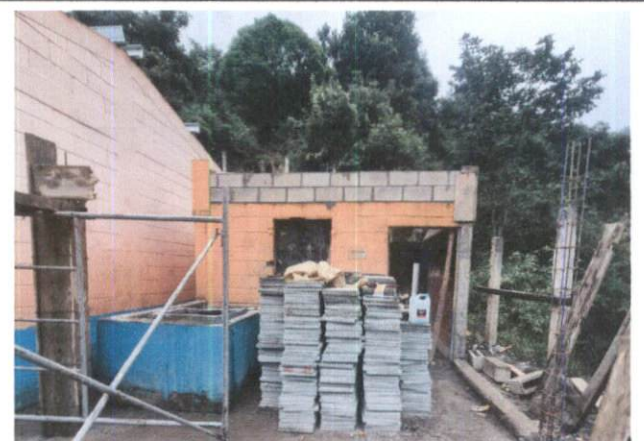
Foto 4: Mejoramiento del área de cocina.
