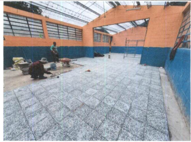
Foto 2: Mejoramiento del piso
